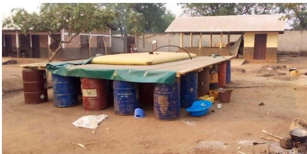
Bladder installé par le CICR
